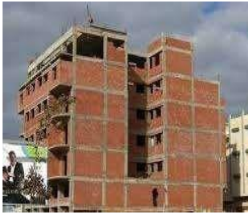
Gambar 1 : Tipikal Konstruksi dengan dinding pengisi bata merah dan bata ringan di Indonesia
